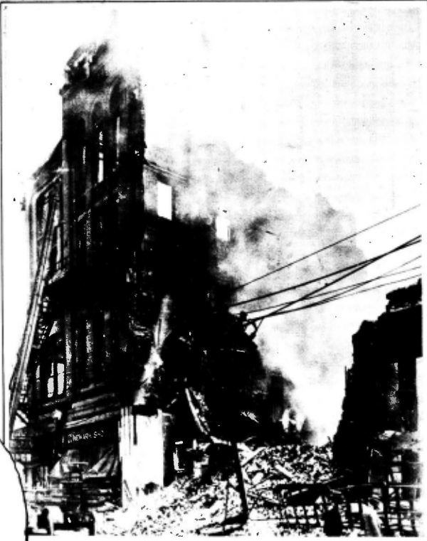
Estado en que quedó el hermoso edificio del Teatro Gillis, de Kansas City, después del terrible incendio que lo redujo a un montón de escombros. La explosión de un contador de gas desencadenó las llamas, pasando de cincuenta—entre muertos y heridos—las víctimas del siniestro.
